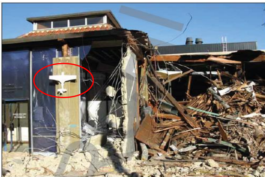
Εικόνα 14 : ΜΕΑ κλάσης I αγκιστρωμένο σε τοίχο κατεστραμμένου κτιρίου [Πηγή : (Austin, 2010)]
